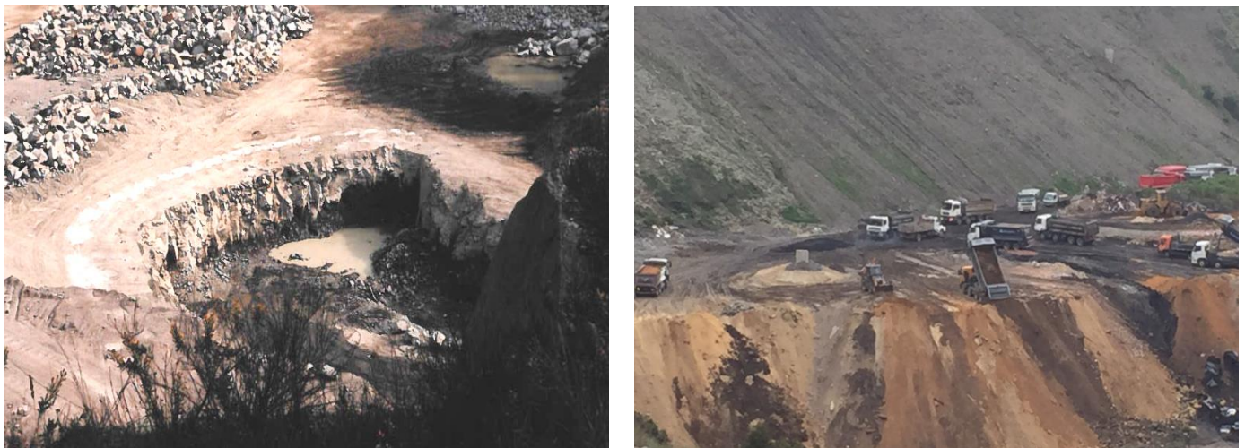
Figura 3 - Bancada pronta para desmonte (esquerda) e atividade de deposição de resíduos inertes (à direita) na Pedreira da Madalena (Arquivo SOLUSEL).
